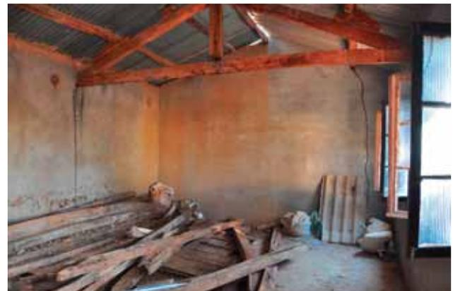
Eindringendes Regenwasser hat seine Spuren im Innern des Gebäudes hinterlassen, aber Fundament und Mauern sind noch brauchbar.
